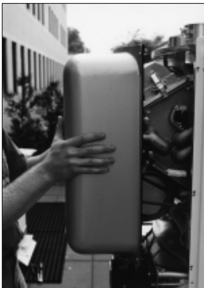
Figuur 7.2.1 Demonteren ventilatiekast
